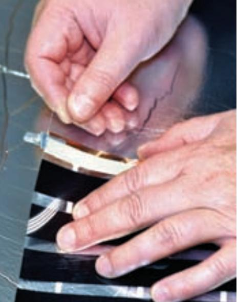
Рис. 8. Установленный на термопленку контактный зажим
