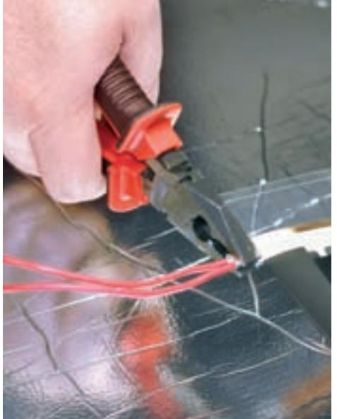
Рис. 16. Надежно зажмите провода в контактном зажиме
