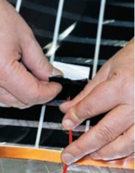
Рис. 23. Датчик прикрепляется к термопленке битумной изоляцией
