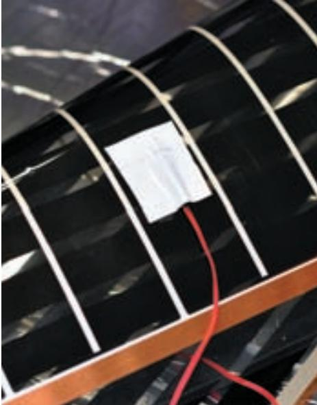
Рис. 24. Установленный и прикрепленный датчик температуры пола. Вид снизу термопленки
