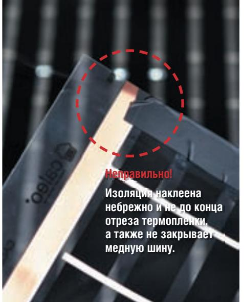
Рис. 14. Пример неправильной установки ПВХ изоляции
