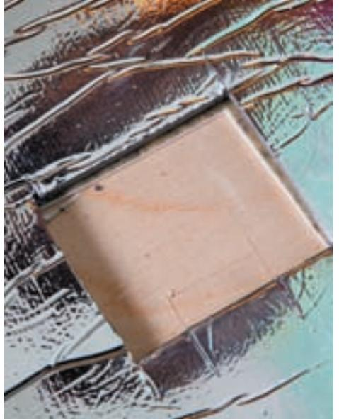
Рис. 22. Отверстие под датчик температуры пола в теплоотражающем материале
