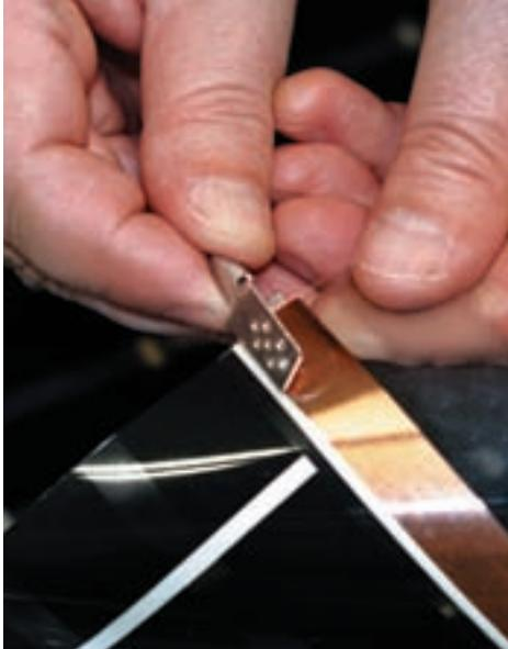
Рис. 9. Установленный на термопленку контактный зажим со стороны медной полосы (снизу)
