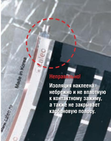
Рис. 13. Пример неправильной установки ПВХ изоляции
