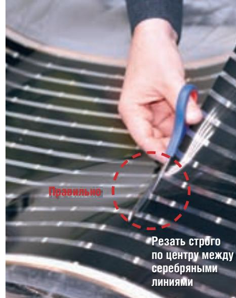
Рис. 7. Разрезание термопленки CALEO PLATINUM посередине между серебряными линиями, расположенными перпендикулярно меднойшине
